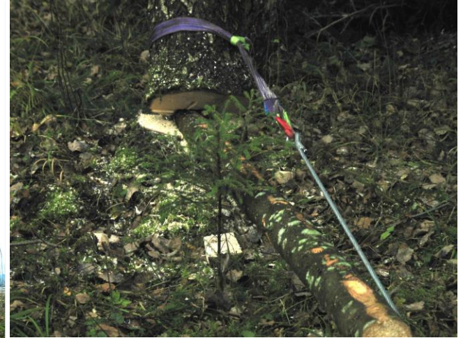
38.att. Palikņa izmantošana iekāruša koka atvieglotai novilkšanai
